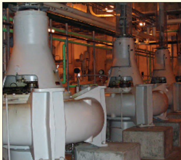
直径200 mmのスプリット・シールでシールされた廃液ポンプは12年以上運転を続けています。
